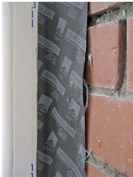
Izmantota nepareiza blīvējošā lente (vēja izolācija, nevis tvaika izolācija) un tās iestrāde veikta nekvalitatīvi un ar neatbilstošu hermētīki.
