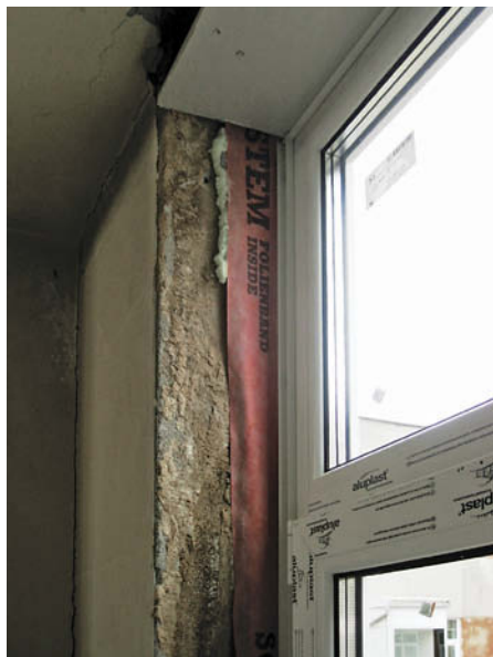
Blīvējošā lente iestrādāta nekvalitatīvi, nav veikta virsmas sagatavošana.
